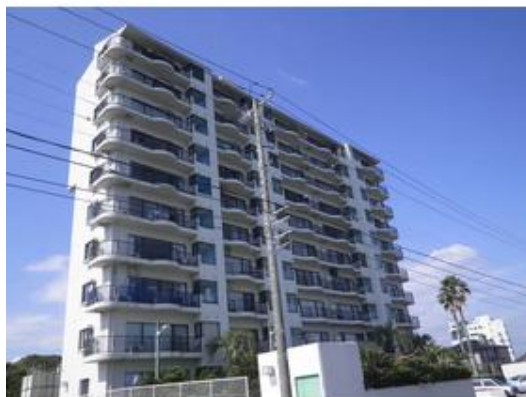
海近のリゾートマンション 夏季はプールもあり
