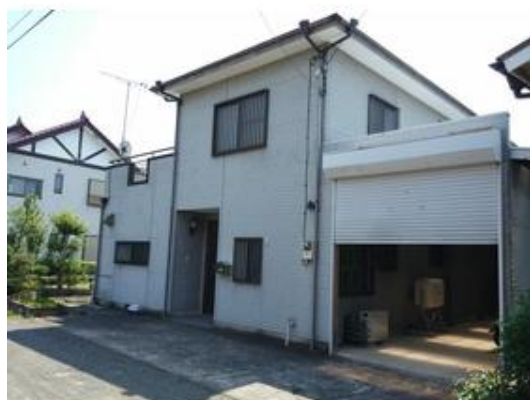
東側より シャッター付倉庫
