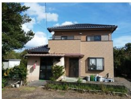
建物正面より
